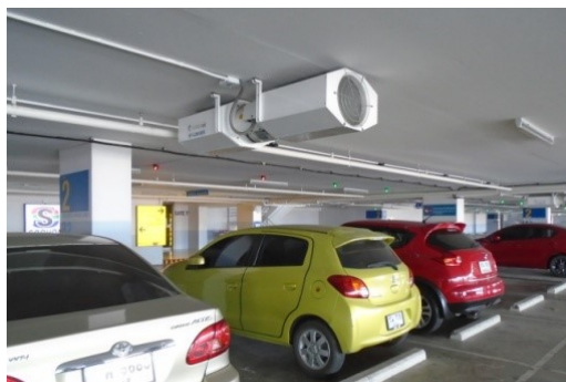
ภาพที่ 4-10 ติดตั้งพัดลมระบายอากาศเพิ่มเติมบริเวณชั้นจอดรถ
