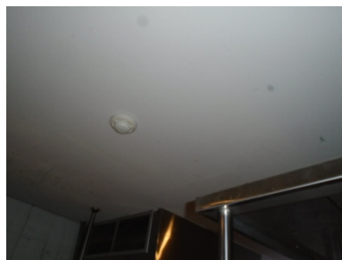
ภาพที่ 4-34 เครื่องตรวจจับความร้อนในห้องครัว
