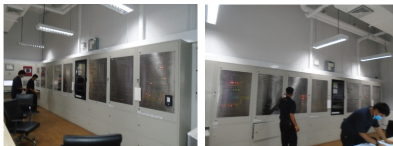
ภาพที่ 4-33 แผงควบคุมศูนย์รับ-ส่งสัญญาณแจ้งเหตุอัคคีภัย
